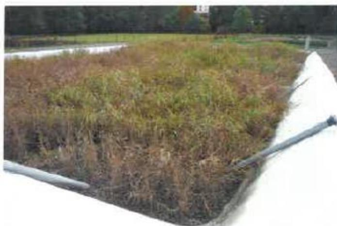
SAINT PIERRE LE VIEUX possède un réseau communautaire d'assainissement collectif de type séparatif avec raccordement de 56 habitations qui conduit à une station d'épuration de type lagunage naturel ayant une capacité portée à 220 EH, à la suite de l'extension réalisée en 2015 par création d'un filtre planté de roseaux en amont.
