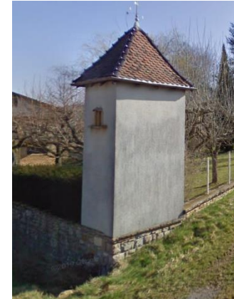
À St point
