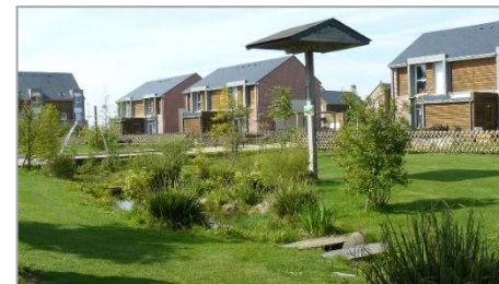
Bassin d'infiltration végétalisé
