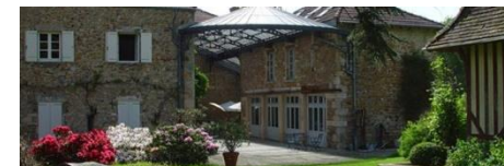
Château Des – St-Léger sous la Bussière
