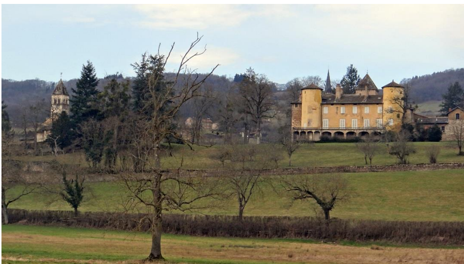
Château de Saint-Point dans la vallée du Valouzin
