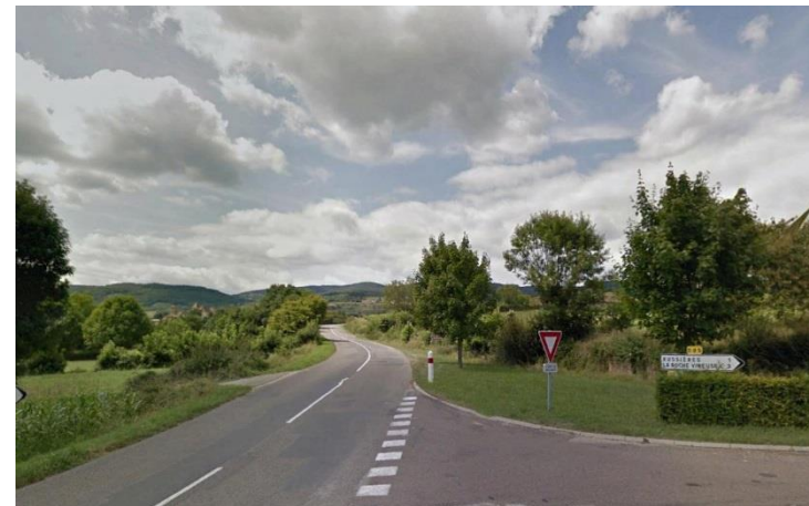
Entrée Est par la Rd 45 avec vue lointaine sur le château et les collines
