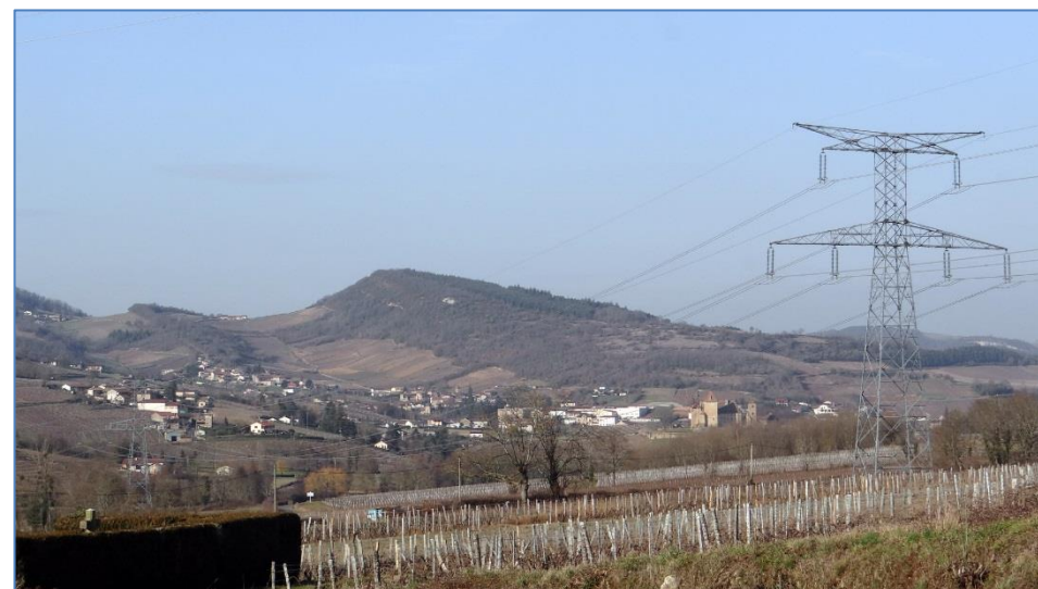
Impact des Lignes électriques à Haute tension dans la vallée de la Petite Grosne
