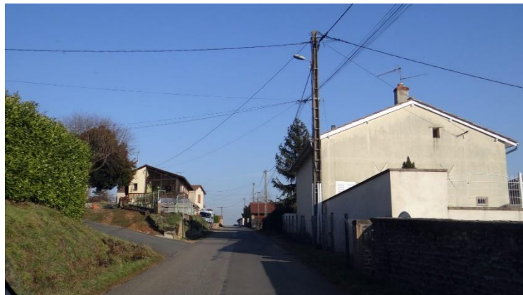
RD 212 à Pierreclos – Réseaux de lignes électriques
