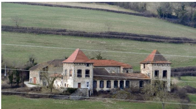
Goze - Bâtiment en mauvais état - Germolles
