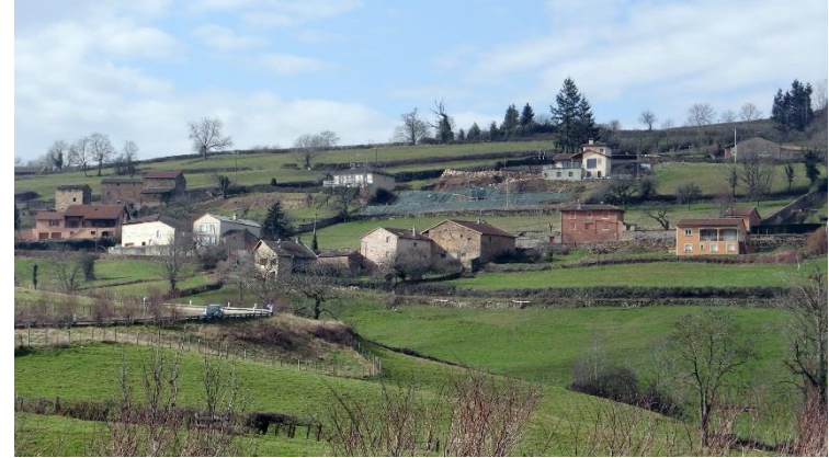
Hameau Les Garennes – Tramayes – Les constructions neuves dispersées entre les hameaux ont brouillé la lecture du paysage. Les couleurs d'enduits et les terrassements n'aident pas l'intégration.
