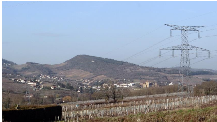
Impact de la ligne HT sur la vue surplombante de la vallée de la Petite Grosne et le château de Pierreclos
