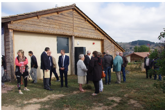
Bâtiment de la chaufferie bois
