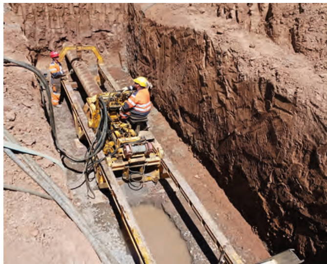
Dévoisement canalisation d'assainissement de la commune de Navour sur Grosne par fonçage sous la RCEA pour une longueur de 130 m
