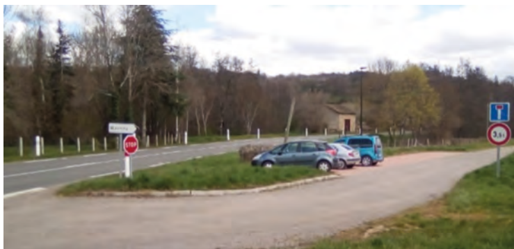
À Navour-sur-Grosne (Clermain) : en bordure de la D987 près de la RCEA – en travaux
