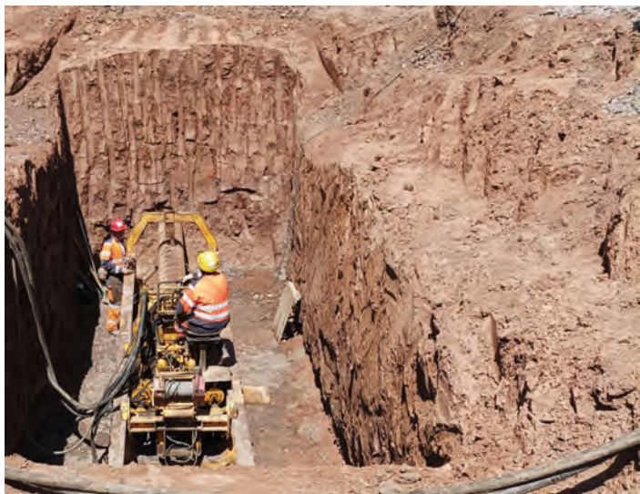
Dévoisement canalisation d'assainissement de la commune de Navour sur Grosne par fonçage sous la RCEA pour une longueur de 130 m
