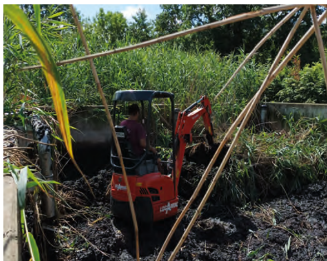
Curage des boues à Pierreclos - Casier de plantés de roseaux N°2 pour environ 42 tonnes.
