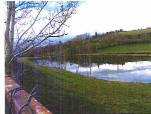
TRAMAYES possède un réseau communautaire d'assainissement collectif majoritairement gravitaire qui conduit à une station d'épuration de type lagunage naturel ayant une capacité de 800 EH.
