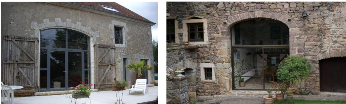
Illustration de fermetures vitrées de porte de grange à privilégier
