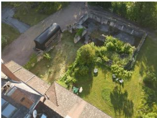
Les murs des anciennes caves où vient se positionner le projet sur un espace artificialisé
