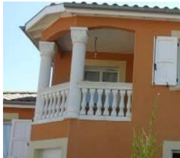
Type de balustres interdits
