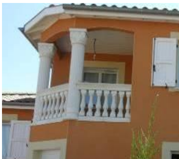
Type de balustres interdits
