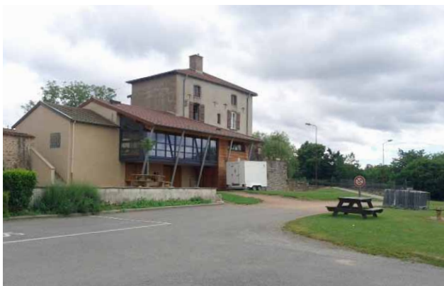
Façade sud du restaurant scolaire vue de l'espace public, l'école à l'arrière plan
